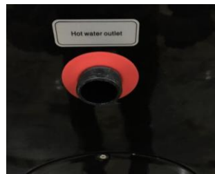
Figure 18: Hot water outlet from Collector plate to tank. Hình 18: Đầu nước nóng từ tấm CFP về bồn.
